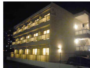
南側からの外観
