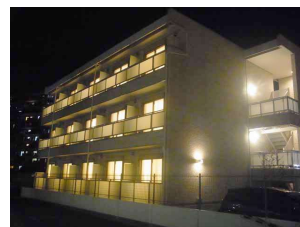
南側からの外観
