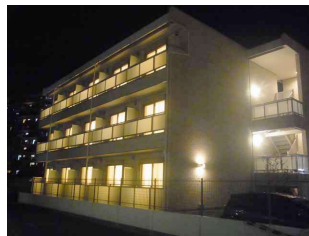
南側からの外観
