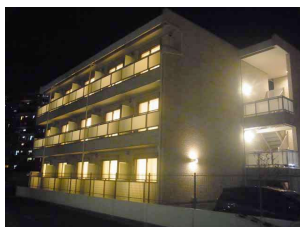
南側からの外観
