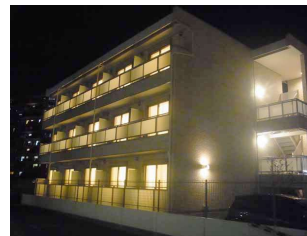
南側からの外観
