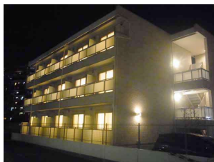
南側からの外観
